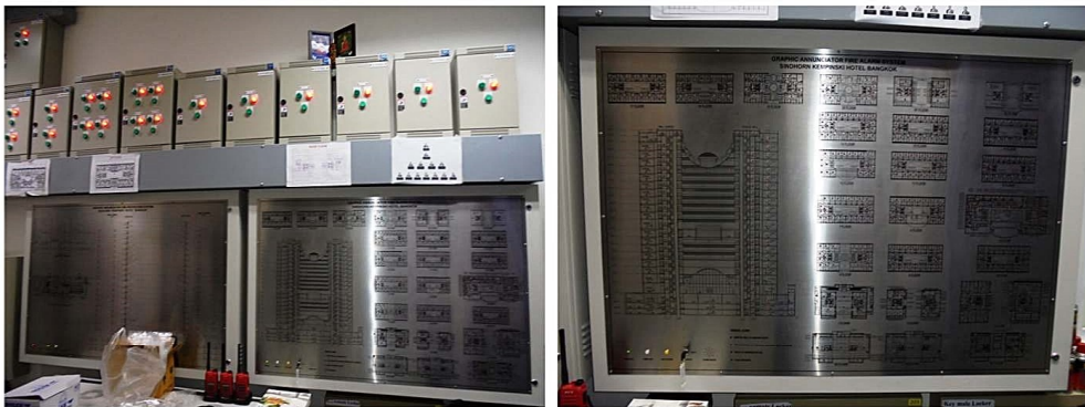
ภาพที่ 4-19 แผงควบคุมการรับส่งสัญญาณแจ้งเหตุเตือนอัคคีภัย
