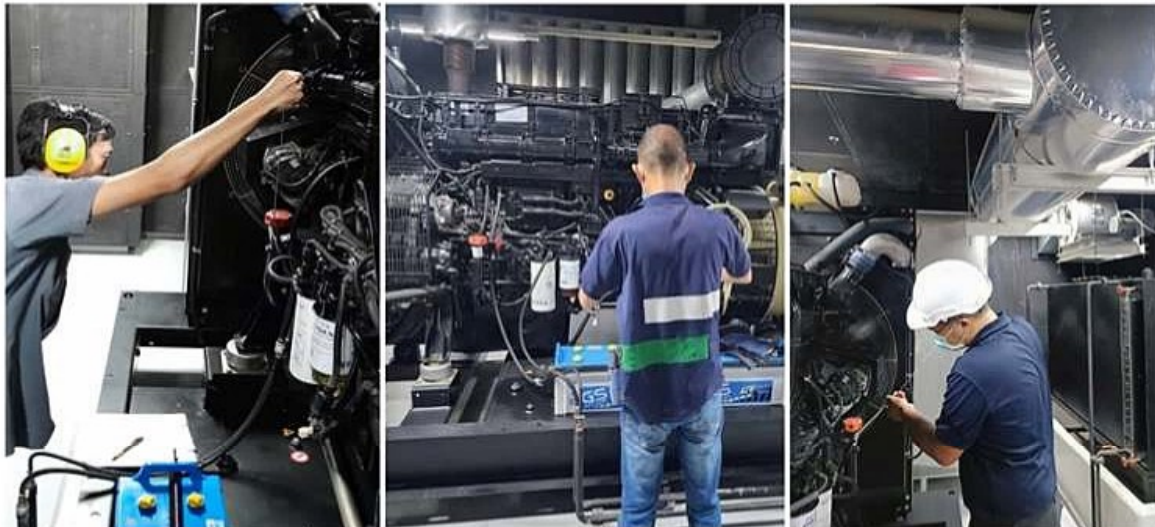
ภาพที่ 4-41 ตรวจสอบดูแลรักษาระบบเครื่องสำรองไฟฟ้าฉุกเฉิน (Generator)
