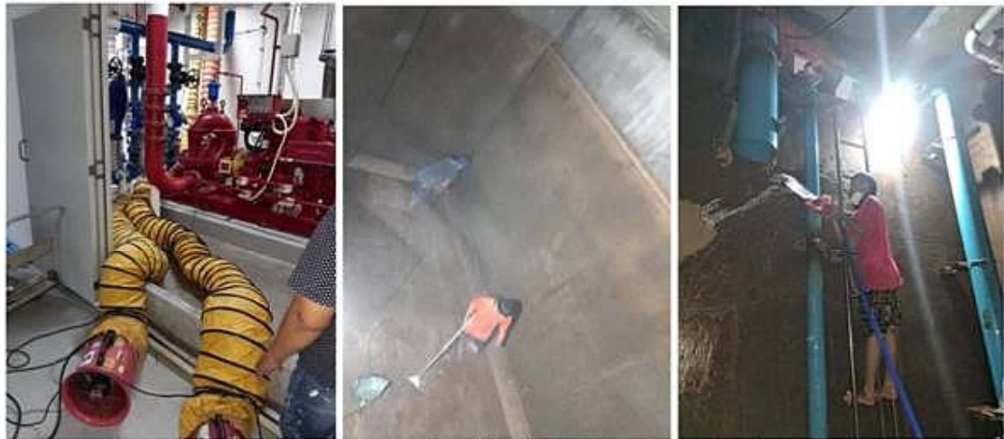
ล้างทำความสะอาดถังสำรองน้ำใช้ ที่เรสซิเดนซ์แอพาร์ตเมนต์เคมปินสกี
