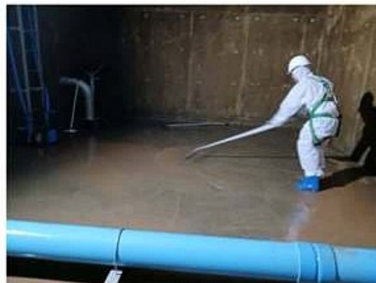
ทำความสะอาดถังสำรองน้ำใช้ที่ โรงแรมสินธร เคมปินสกี ภาพที่ 4-40 ล้างทำความสะอาดถังสำรองน้ำใช้
